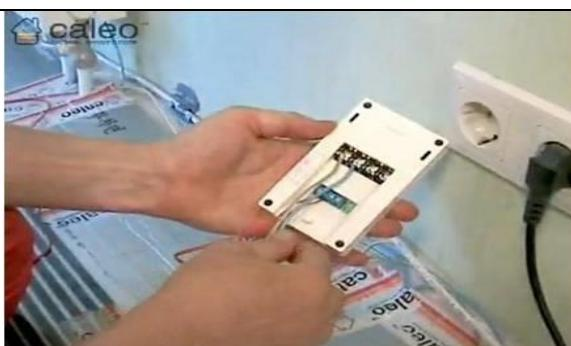
Spojite sve elemente na termostat, prema uputama proizvođača (Grijaci film, podni senzor i napajanje). Vodiče senzora i grijaćeg filma provucite kroz odgovarajuće instalacijske cijevi (senzor u jednu, vodiče filma u drugu, ili u kanalicu ako je nadžbukno).
