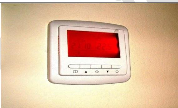
Montirajte termostat u/na zid (ovisno o modelu).
