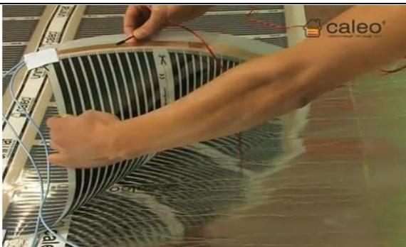
Podni senzor postavite ispod grijaćeg filma. Zaliđepite podni senzor za film (Optimalno mjesto je na oznaku za rezanje grijaćeg filma).
