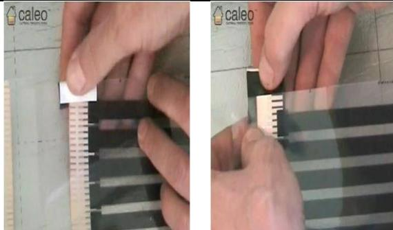
Izolirajte na rezu grijajući film, na kraju gdje ne dolazi spojnicu.
