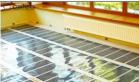
Nakon rezanja na željenu duljinu postavite grijaci film na podlogu (izolaciju).
