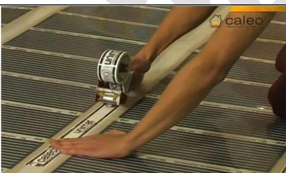
Pričvrstite grijaci film na izolacijski materijal pomoću ljepljive trake.
