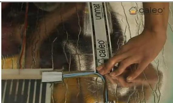
Samoljepivom trakom učvrstite vodiče za termoizolaciju.
