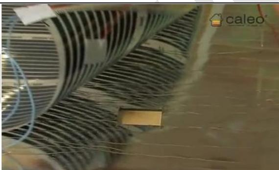
Izrežite u termoizolaciji otvor za podni senzor.
