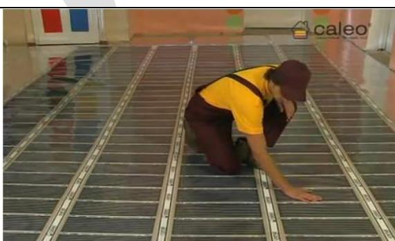
Prije postavljanja podne obloge provjerite rad sustava. Ako sami postavljate podno grijanje, a nemate odgovarajući alat, provjerite dodirom svaki film. **Preporučujemo da spajanje na električnu mrežu prepustite električaru.**
